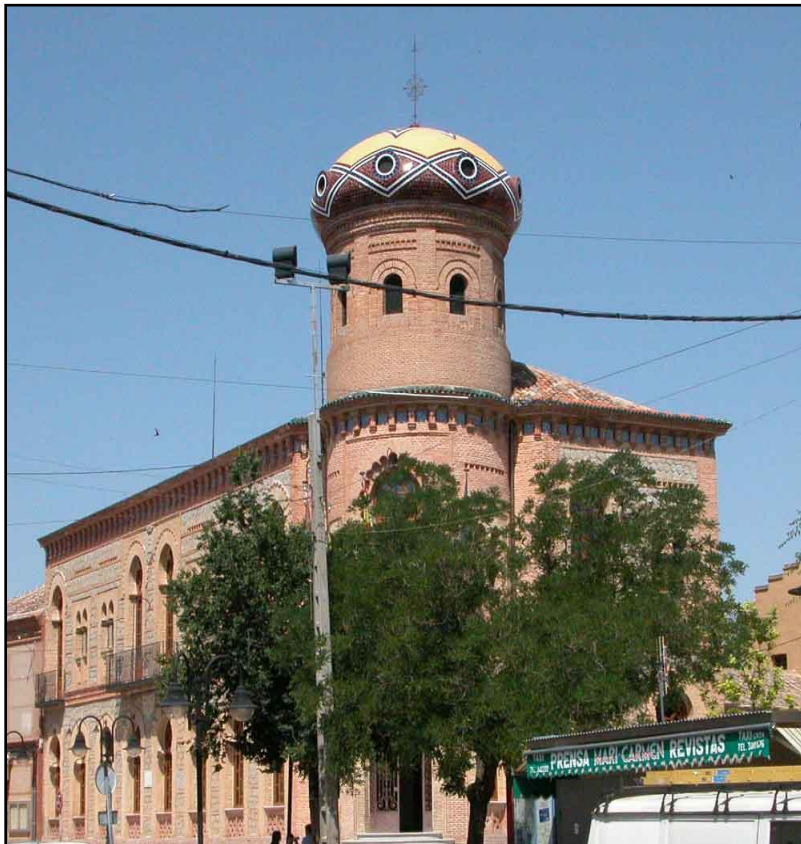
Fachada frontal y lateral del ayuntamiento de Mora en la actualidad
