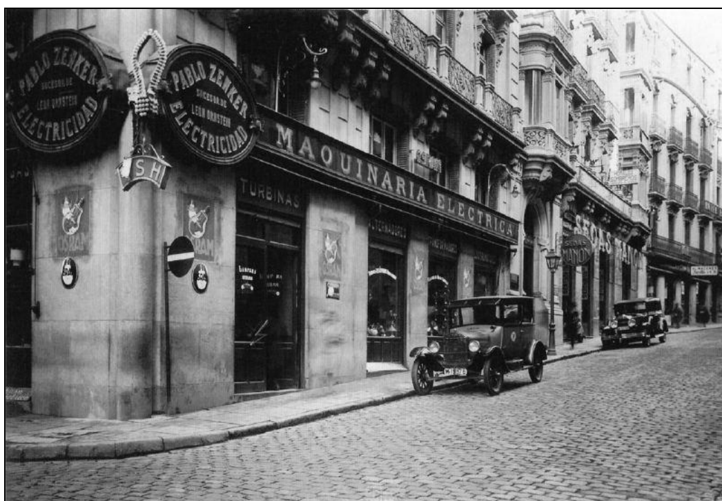
Establecimiento de la casa Pablo Zenker en la calle del Maestro Victoria de Madrid (1926)
